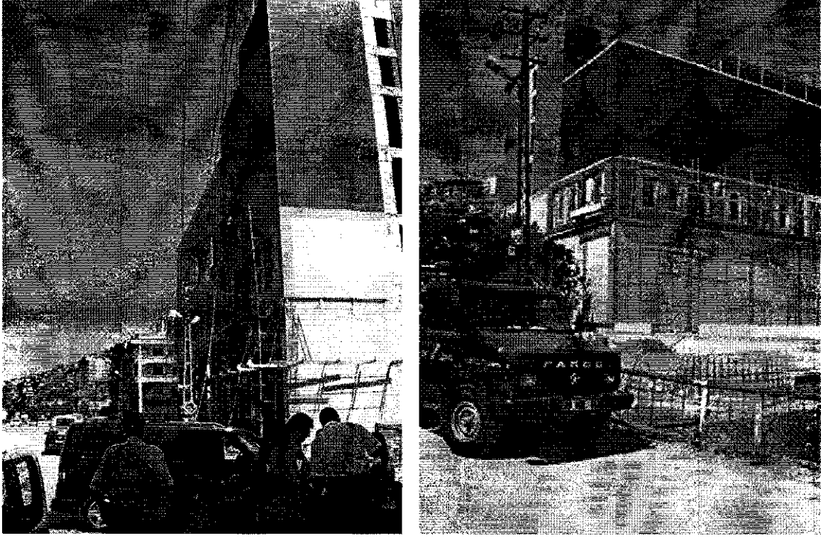
Şekil 1 ve 2: Dava konusu parselde keşif günü saptanan yapının ön ve arka cepheden görüntüsü
